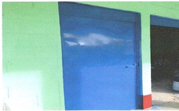
Foto 3: MEJORAMIENTO DE PINTURA Y REPARACION DE 6 PUERTAS DE METAL
