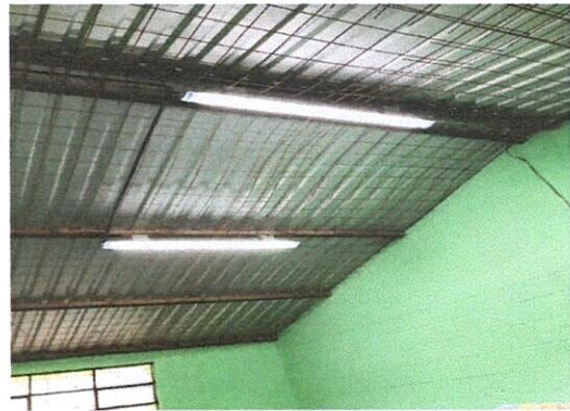
Foto 2: MEJAMIENTO DE SISTEMA ELÉCTRICO (TOMACORRIENTES Y FOCOS) EN 6 AULAS Y CORREDOR DEL ESTABLECIMIENTO
