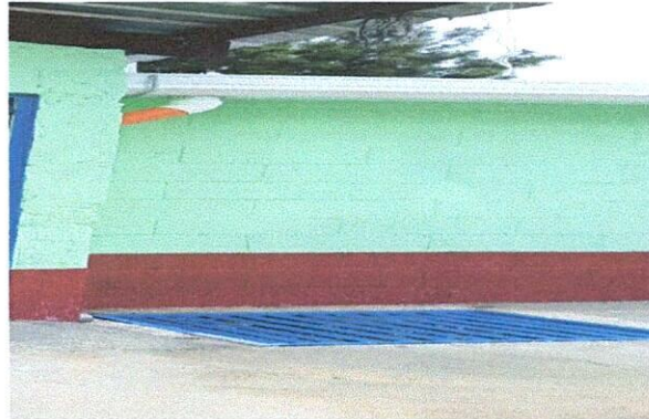
Foto 4: MEJORAMIENTO DE 24 ML DE TUBERIA DE AGUA PLUVIAL MAS UNA CAJA PARA TUBERIA
