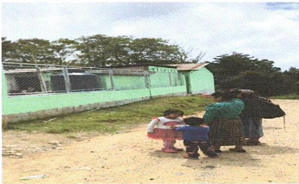
Foto 1: MEJORAMIENTO DE REPARACION DE 40ML DE CIRCULACION CON MALLA.
